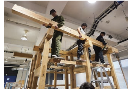
釘を一本も使わず骨組みを制作する伝統的工法を修得。
